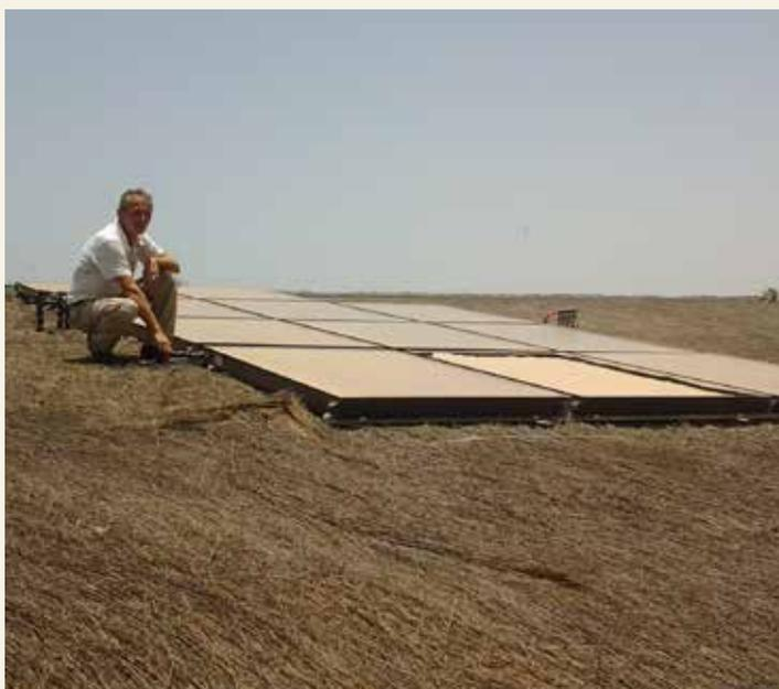
M. Martin Schmitz, personnel technique de l'hôtel Lamantin, avec les panneaux solaires installés dans la toiture de l'hôtel, utilisés pour le chauffage de l'eau de l'établissement (Photo: Projet COAST)
