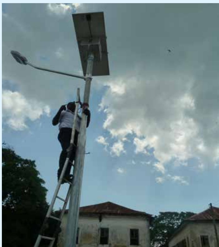
Installation des lampadaires solaires à Bagamoyo, une activité sous la composante thématique SGE/TEST (Photo: Projet COAST)
